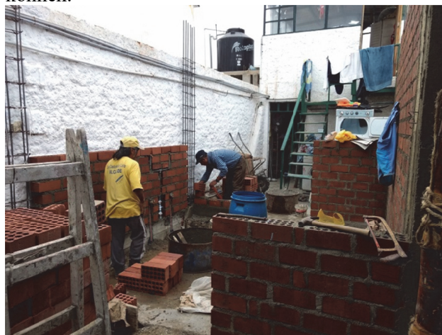
Bau der neuen Küche
